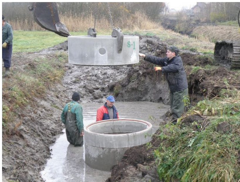
Figur 2: Installation av filterbrunn i Polen
